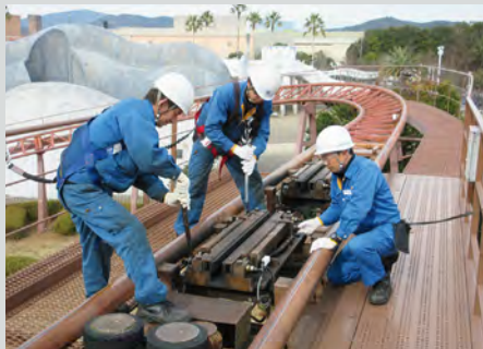
アトラクション施設保守点検
